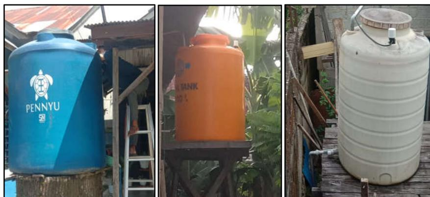
Gambar 7. Beberapa tandon yang telah terpasang WLC tipe Radar
