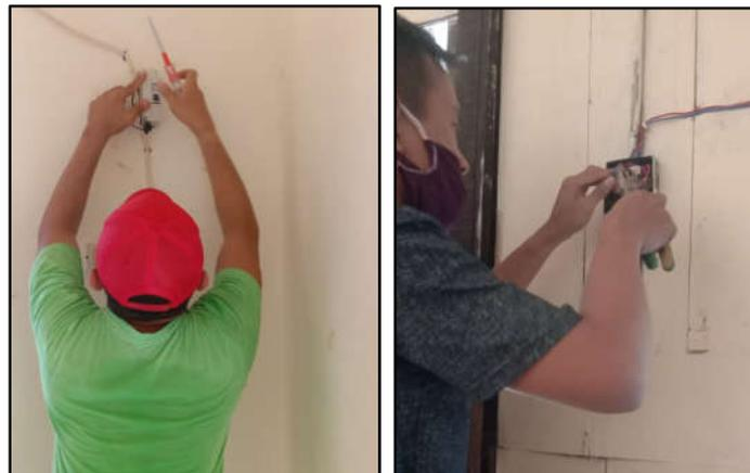
Gambar 6. Pemasangan cover MCB dan MCB
