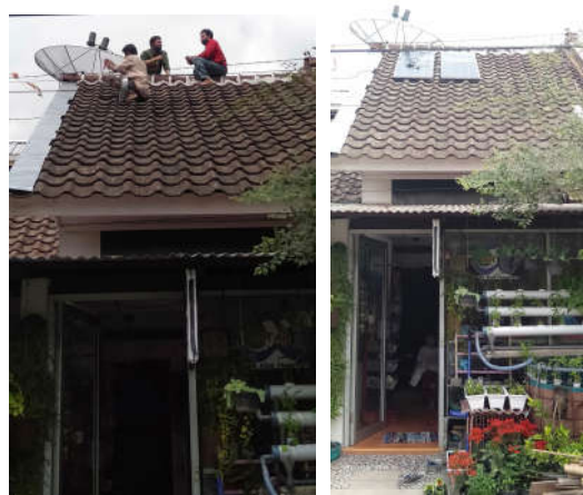
Gambar 10. Pemasangan Panel Surya
