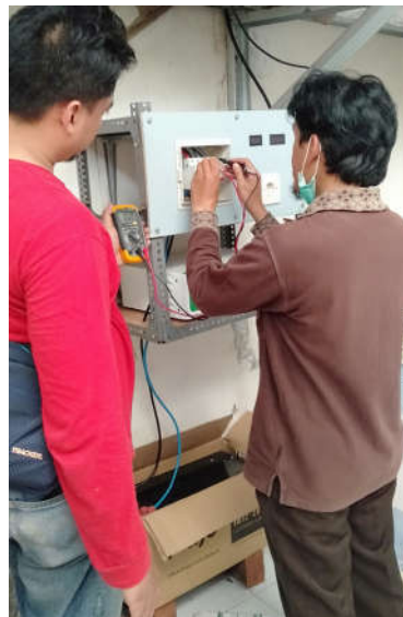
Gambar 11. Pemasangan Controller Hybrid dan Baterai
