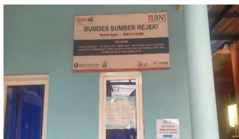
Gambar 1. Keadaan Gedung BUMDES Sumber Rejeki
