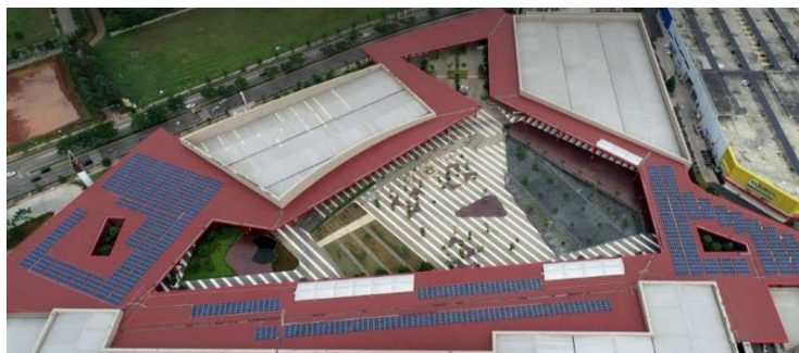
Gambar.1. Pembangkit Listrik Tenaga Surya (PLTS) roof top Qbig BSD City
