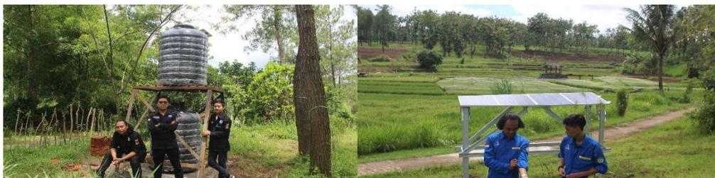
Gambar 13. Tahap Pemasangan Frame Tandon dan Panel Surya pada Lokasi Taman Suko
