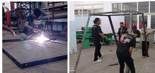
Gambar 8. Tahap pembuatan struktur rangka untuk tandon
