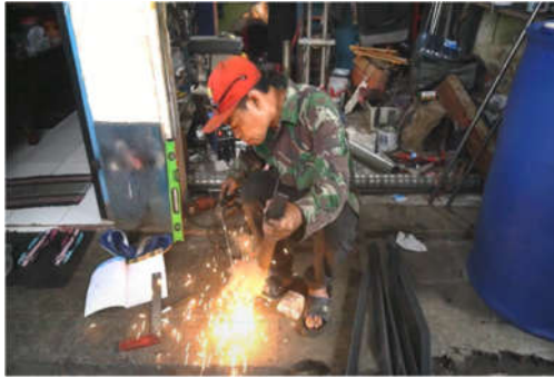
Gambar 8. Kondisi Lingkungan Bengkel tidak rapi dan kotor
