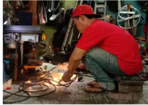
Gambar 9. Pekerjaan Pengelasan Tanpa Menggunakan APD
