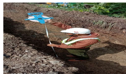
Gambar 4 Pengukuran Galian jalur Pipa
