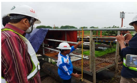
Gambar 9 Pengukuran Besi pada jembatan Pipa /outlet
