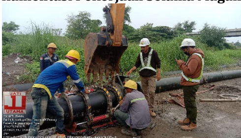
Gambar 1 proses penyambungan pipa HDPE
