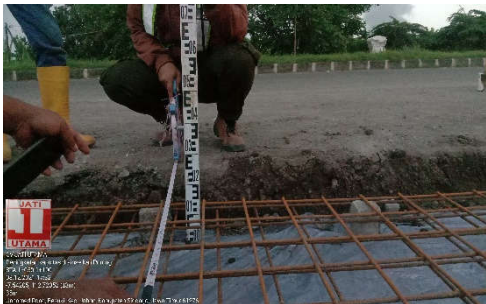
Gambar 7 Pengukuran galian pembuatan plat beton bertulang K-250
