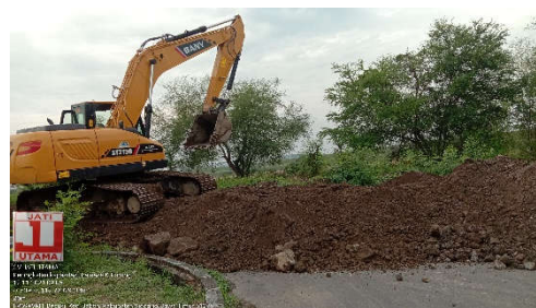
Gambar 2 proses penggalian jalur pipa HDPE
