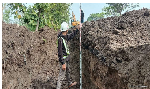
Gambar 3 Pengukuran Galian jalur Pipa
