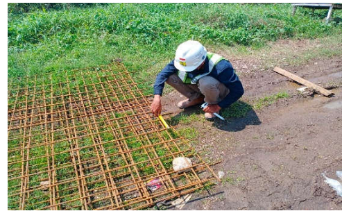
Gambar 8 Pengukuran Besi weremesh pembuatan plat beton bertulang
