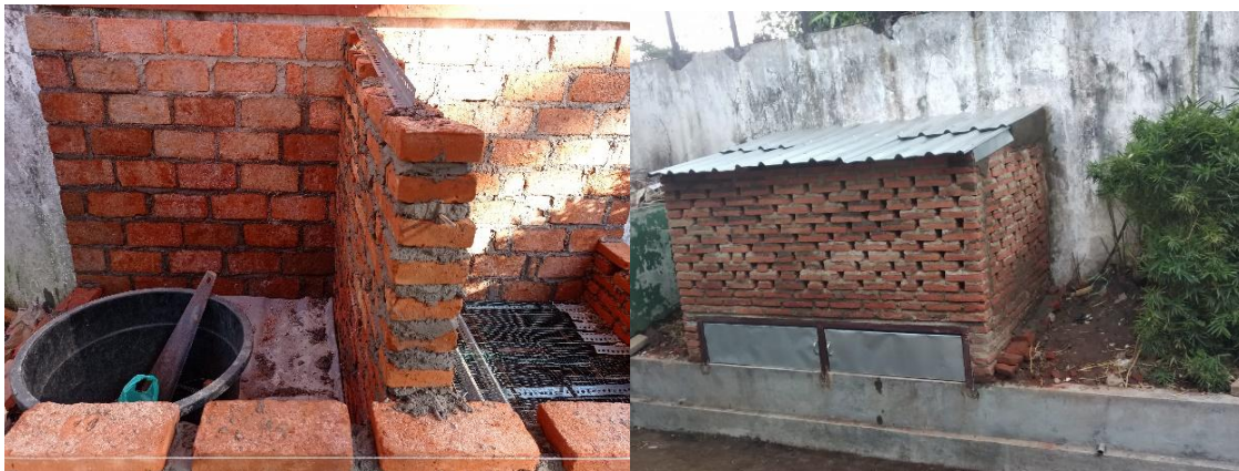
Gambar 2. Konstruksi Bata Terawang
