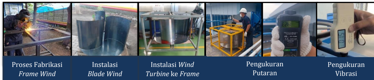
Gambar 5. Proses Pembuatan Wind Turbine dan Instalasi
