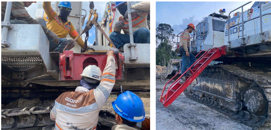
Gambar 4. Instalasi dan Pengujian Tangga Hidrolik
