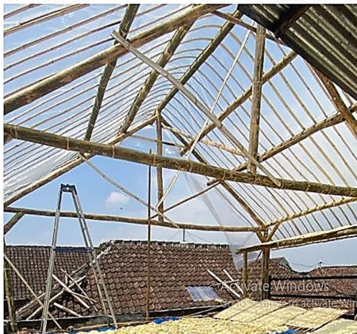
Gambar 4. Pemasangan Plastik UV
