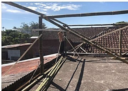
Gambar 3. Pemasangan Kerangka Greenhouse
