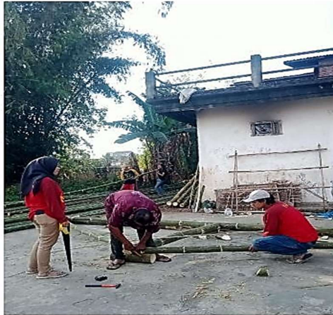
Gambar 2. Kegiatan Pembuatan Kerangka Greenhouse
