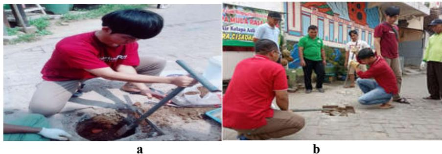
Gambar 2a-b. Pembuatan Lubang Biopori
