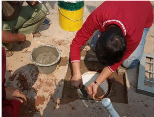
Gambar 3. Pemasangan Ember Pada Lubang Biopori
