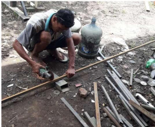
Gambar 4. Pemotongan besi untuk tiang papan nama jalan
