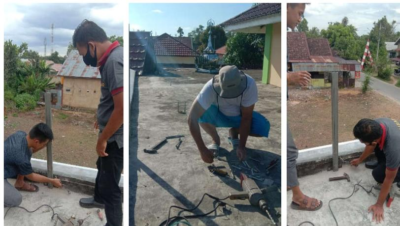
Gambar 6. Proses Pemasangan Tiang Besi Hollow
