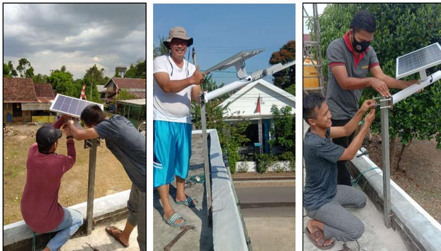
Gambar 7. Proses Pemasangan Panel Surya dan Lampu Penerangan Pada Besi Hollow
