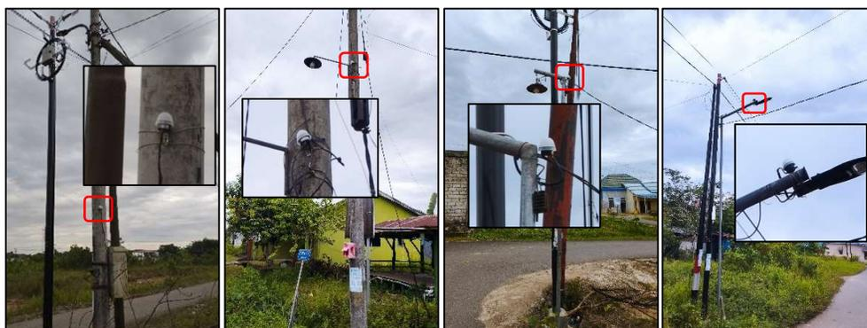
Gambar 8. Hasil instalasi *photocell* di beberapa titik lampu PJU
