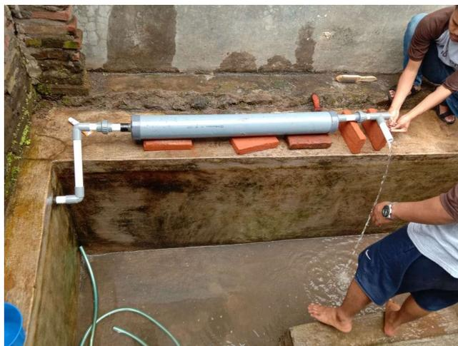
Gambar 2. Proses Pemasangan Filter Air
