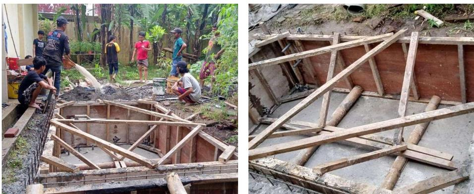
Gambar 4. Proses Pengecoran
