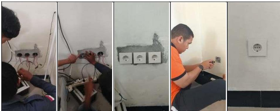
Gambar 14. Pemasangan stop kontak CP; a) 3 stop kontak di ruang imam, b) 2 stop kontak di ruang makmum
