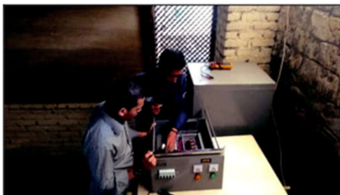
Gambar 4. pemasangan panel kontrol otomatis (ATS) di lokasi mitra
