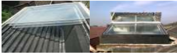
Gambar 1. Solar water heater sederhana menggunakan pelat penyerap ganda dan reflektor ( Farid dan Ismail, 2010)
